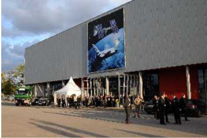
Ansicht der neuen Raumfahrthalle
